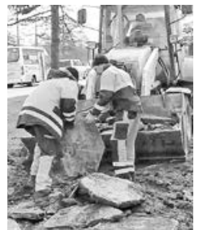
Демонтаж шестигранников в мае этого года.
