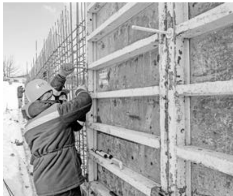
Пока строители в самом начале пути, идет заливка фундаментной ленты.
