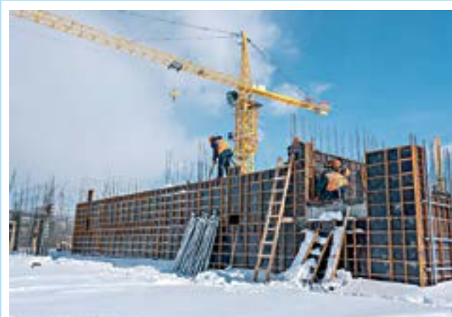
Стены первых домов уже поднимаются.
