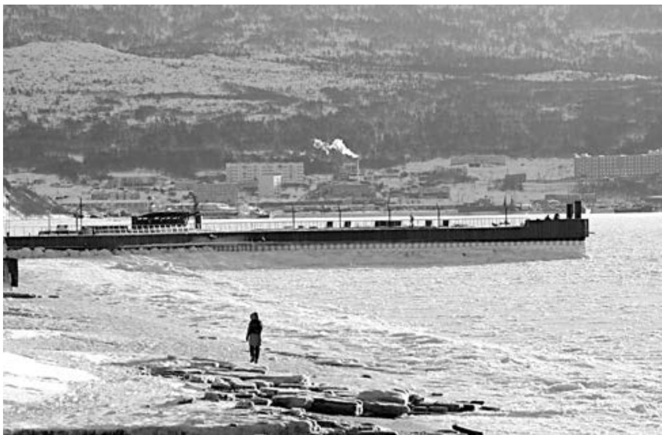
Наша гордость - новый пирс.
